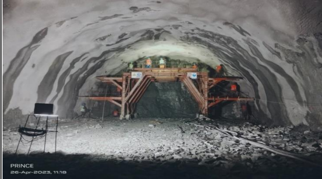
TRT01 DS Drilling for blast
