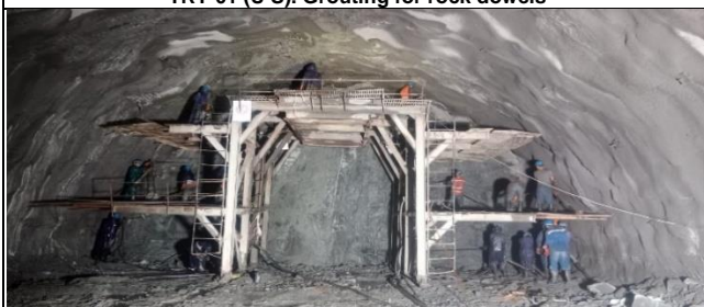
Trt02 ds drilling for blast
