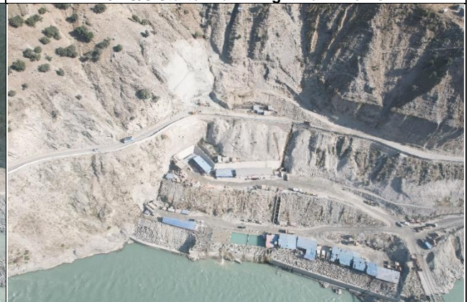
MW01-LBTDT Outlet portal excavation
